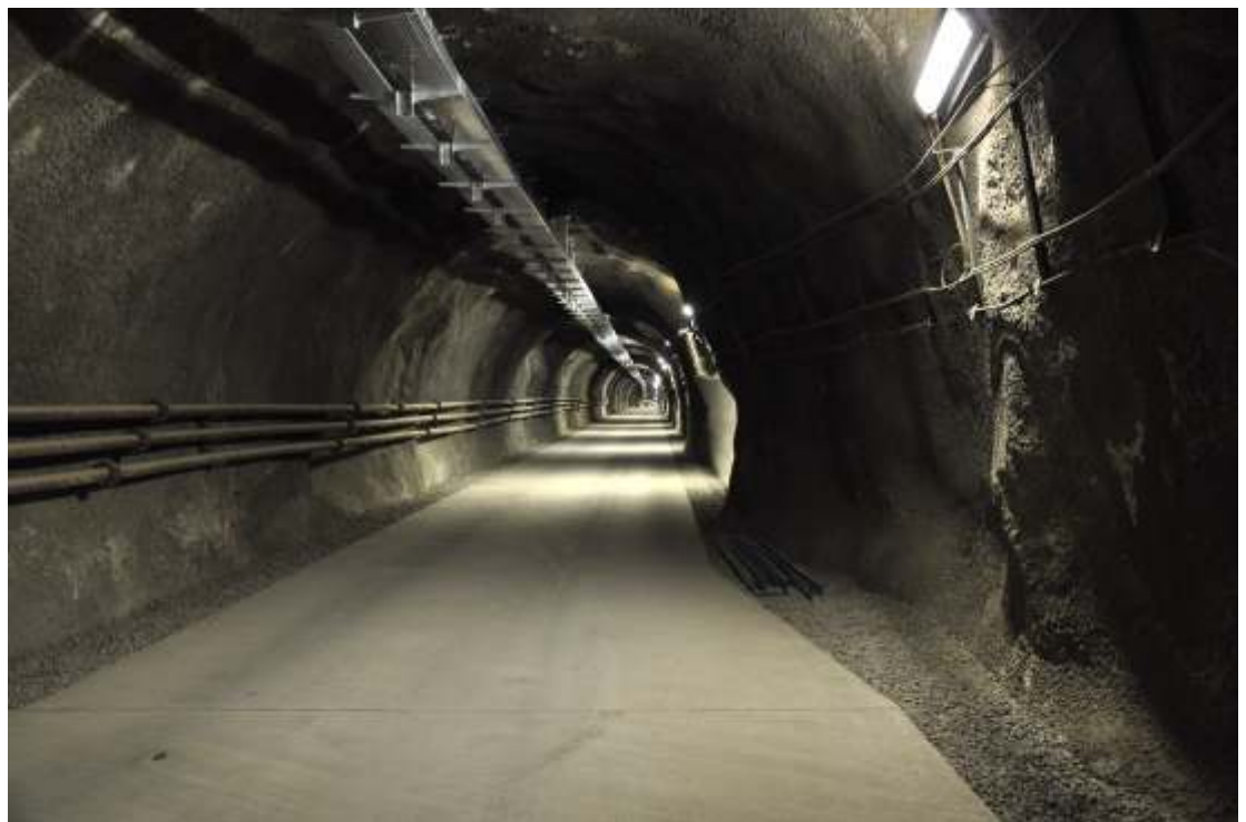
NRHT felszín alatti tároló közlekedő alagútja
