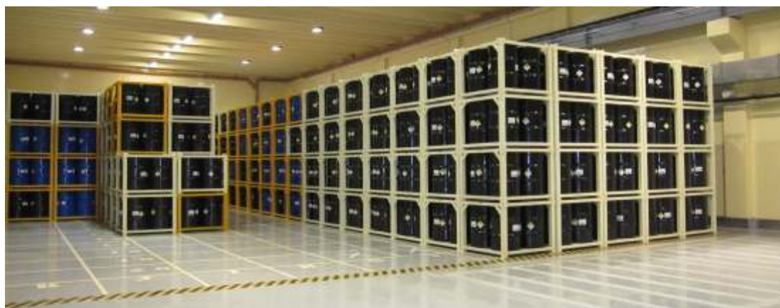
NRHT technológiai épület
