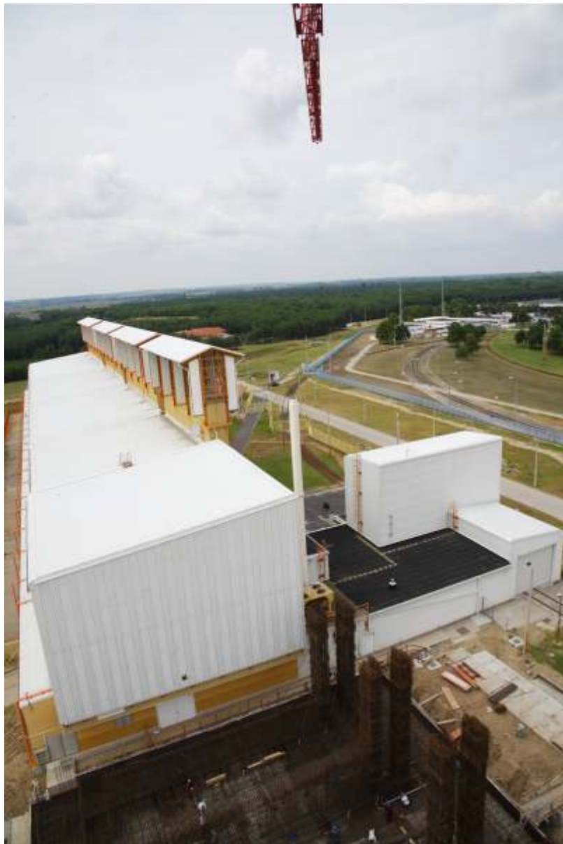
KKÁT építési munkálatai
