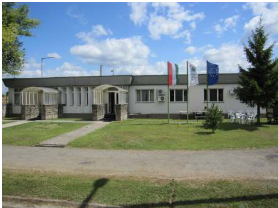
RHFT üzemi épülete
